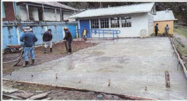
Foto1: Sustitución de piso de concreto de un módulo
