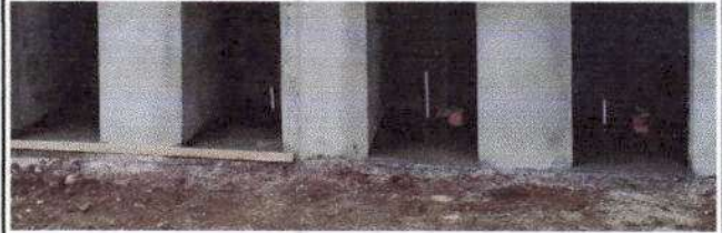
Foto 2: Sustitución de piso de concreto de los baños
