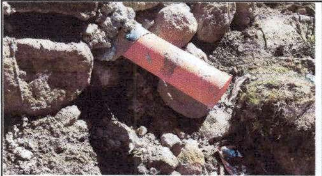
Foto 4: Sustitución de tubería pvc aguas negras
