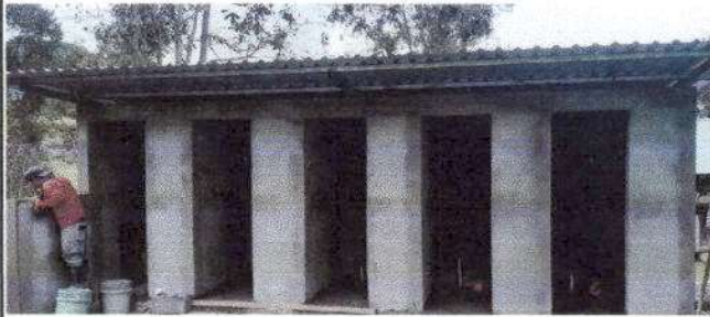
Foto1: Sustitución de puertas de los baños
